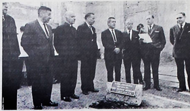
A un costo de 800 mil dólares, será construido un moderno edificio de propiedad del Banco Boliviano Americano. Ayer en la mañana se efectuó la colocación de la piedra fundamental, en presencia de autoridades del gobierno, representantes de la banca estatal, banca privada, Superintendencia de Bancos y delegados de la industria y comercio nacional. La bendición estuvo a cargo de Mons. Andrés Kennedy y en la misma oportunidad pronunciaron discursos el presidente del Banco Boliviano-Americano, Humberto de Rada, el Ministro de Industria y Comercio, el Alcalde Municipal, Gral. Hugo Suárez Guzmán y, finalmente, el Superintendente interino de Bancos. En la fotografía, los asistentes a la ceremonia, celebrada en los terrenos de la calle Loayza esquina Av. Camacho, escuchan el discurso de Humberto de Rada.
