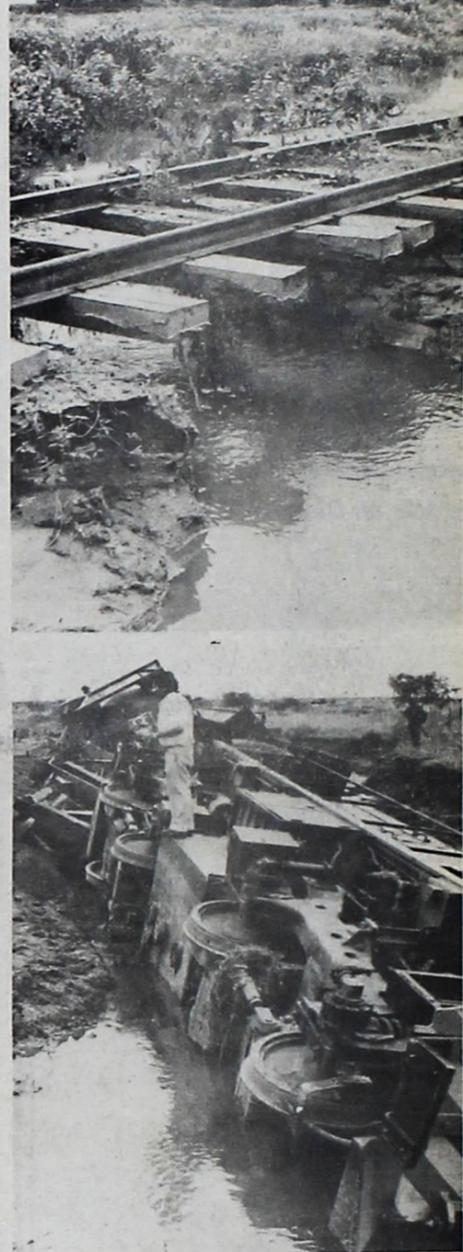
ACCIDENTE FERROVIARIO.- Una erosión causada por el agua en la línea férrea a Santa Cruz, como se observa arriba, produjo el desmoronamiento de una locomotora y dos vagones en las inmediaciones de la ciudad, dentro del Parque Industrial. El accidente se produjo esta semana y la mazamorra acumulada sobre la vía, hace peligroso cualquier viaje en ferrocarril (Foto PRESENCIA, Santa Cruz.)
